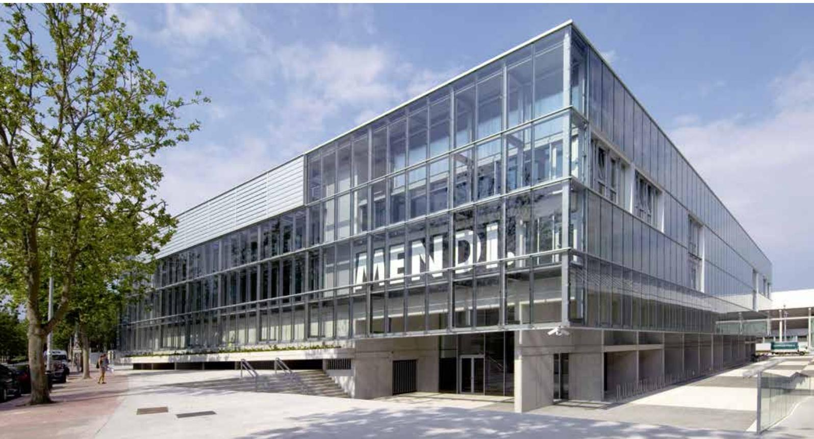
El diseño también incluye un sistema de control de clima de doble cristal que sirve como amortiguador de aire térmico capaz de modular la ganancia solar.
