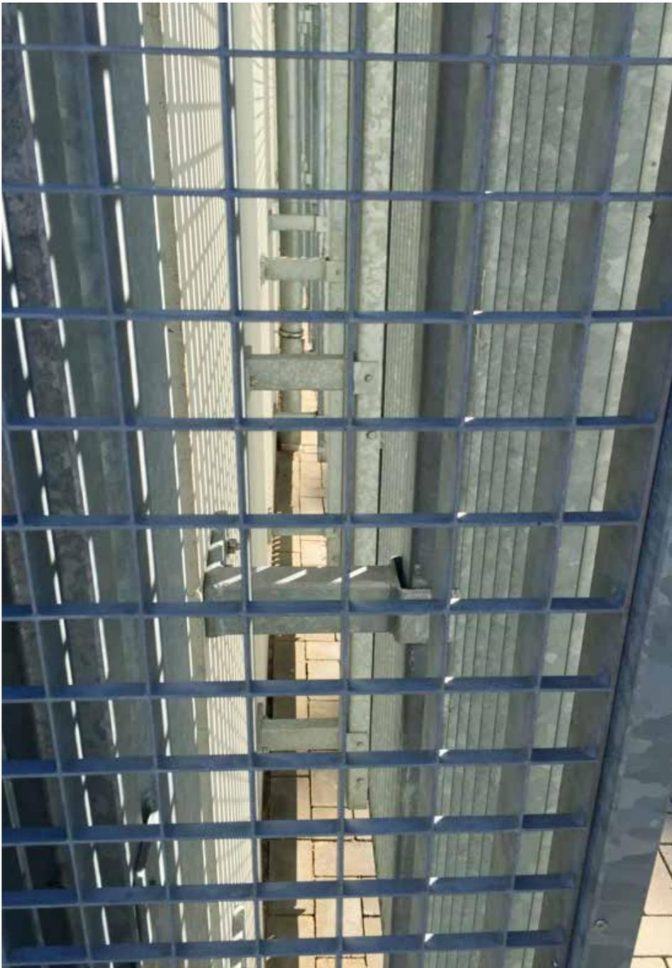
En una fase de prueba, se construyeron doce nuevas instalaciones en siete lugares. Se priorizaron aspectos como higiene, la actuación anti-vandalismo y la prevención del delito durante el uso. Para el diseño se utilizó una doble fachada galvanizada, una subestructura para soportar el edificio y una malla que cubre la subconstrucción. De esta manera el módulo queda protegido contra vandalismo y graffiti. Un mosaico brillante añade un acabado más suave y juguetón a la elevación frontal.
