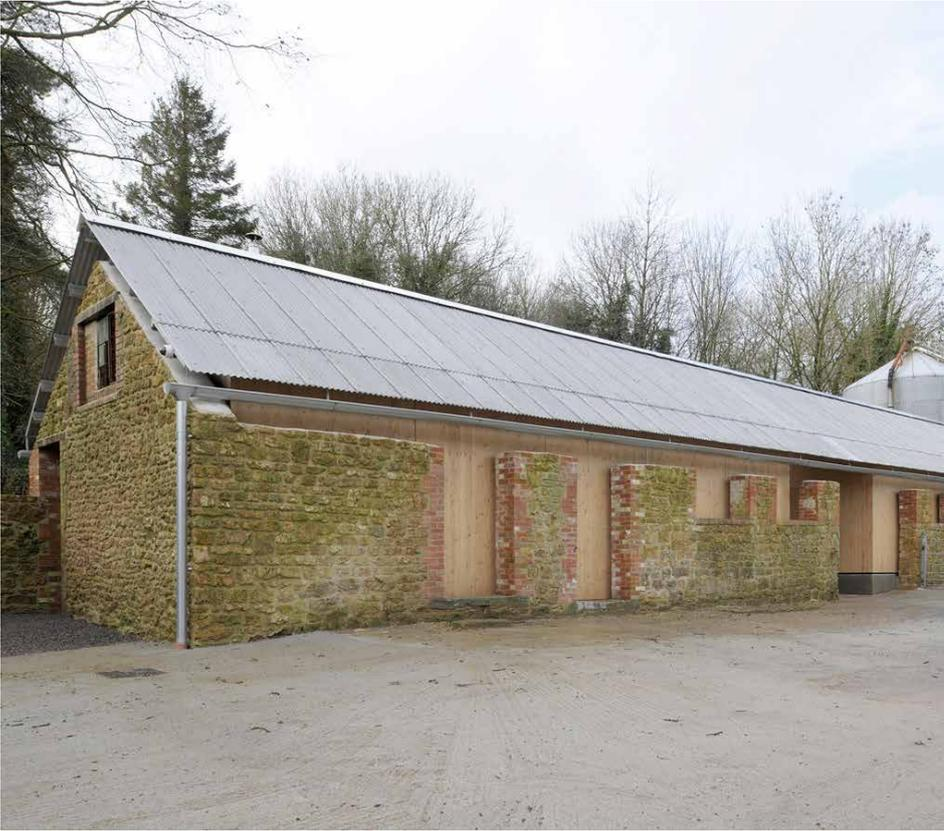
Un bastidor de acero galvanizado, que abarca toda la longitud del edificio, soporta el techo de fibra de cemento perfilado y proporciona un contrapunto a los paneles CLT. Esto se refleja externamente en el uso del galvanizado en los canalones y las bajantes. Hermosamente perfiladas, las puertas galvanizadas y los detalles de drenaje contrastan aún más con los acabados mínimos utilizados en el interior.
