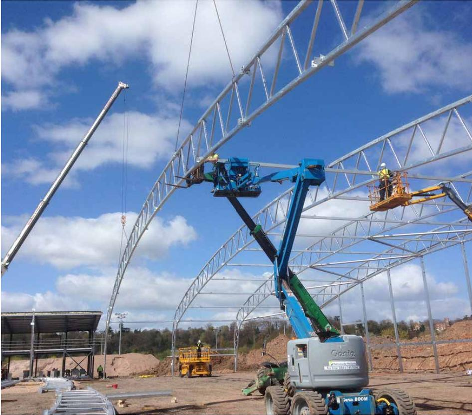
El edificio abarca 66 metros y mide 112 metros de largo. El acero galvanizado es una parte integral de la estructura. Además de ser estéticamente agradable, sus excelentes cualidades fueron la opción obvia para hacer frente a los altos niveles de condensación con un mínimo mantenimiento.
