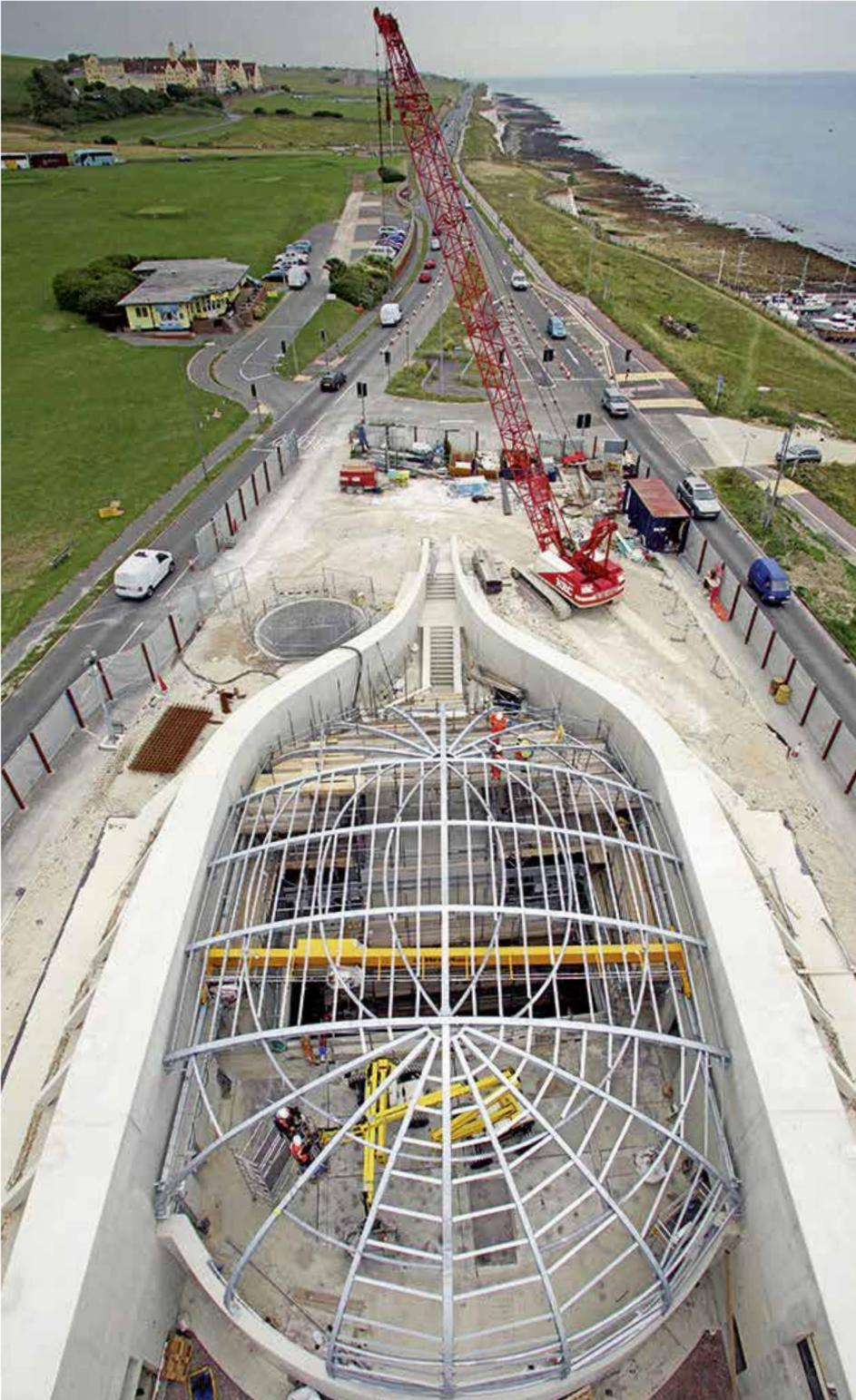
Todas las estructuras consisten en complejos techos curvos que forman parábolas con paredes laterales curvadas. Cubierto de sedum, el techo se integra en las llanuras del sur, y forma el techo verde más grande de toda Gran Bretaña. La gran estructura de acero galvanizado se divide en dos partes mediante una junta de movimiento situada a lo largo de una marquesina de acero que conecta el Centro de Reciclado de Lodos al edificio principal, un área que se encuentra sobre los ejes de la instalación.
