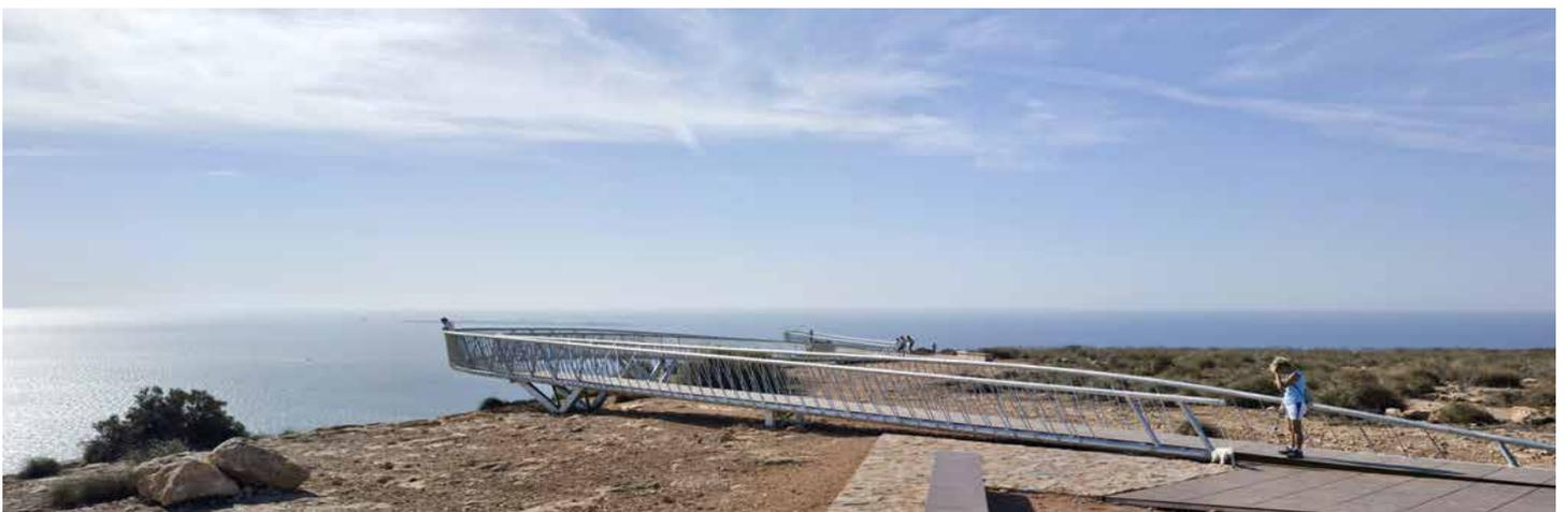
Por el ambiente corrosivo marino, el ajustado presupuesto del proyecto, y la larga durabilidad sin mantenimiento, el material escogido para esta actuación no pudo ser otro que el acero galvanizado.
