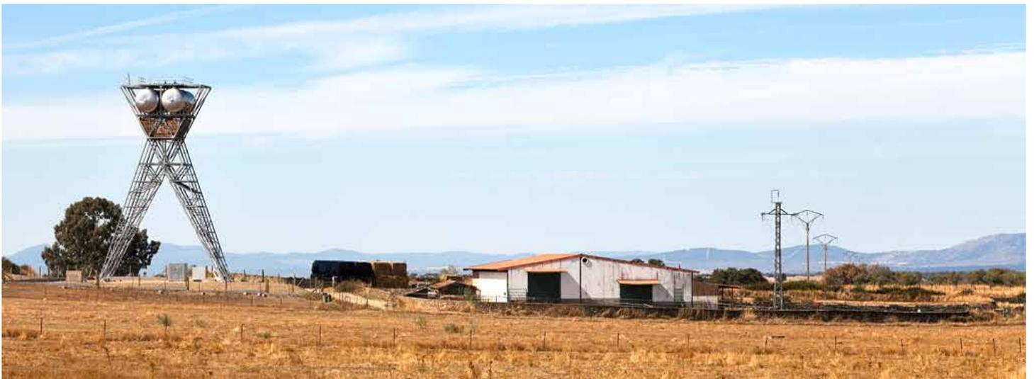
Los dos depósitos, dispuestos de forma paralela, producen un plano de simetría, aplicado a la totalidad de la estructura. Esta se dispone en forma de cuatro pórticos unidos por cruces de san Andrés. La considerable apertura de los puntos de apoyo dota a la torre de particular estabilidad ante esfuerzos horizontales transversales, confiándose la rigidez longitudinal a las uniones diagonales.
