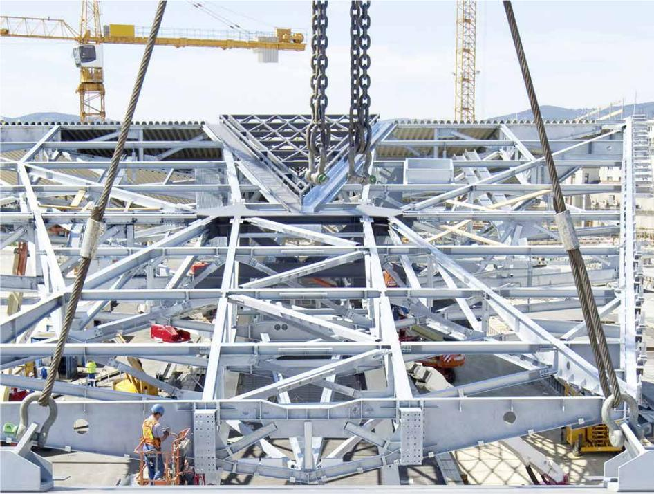
barras y nodos. Todo el techo (incluido el dosel) se compone de más de 57.000 elementos, 286.000 láminas de metal y 340.000 elementos de sujeción escondidos bajo el revestimiento. La creación de la gigantesca estructura fue un reto exigente para los contratistas y la empresa de construcción Unger Steel, no sólo desde un punto de vista tecnológico, sino también en cuanto a la logística del proyecto.
