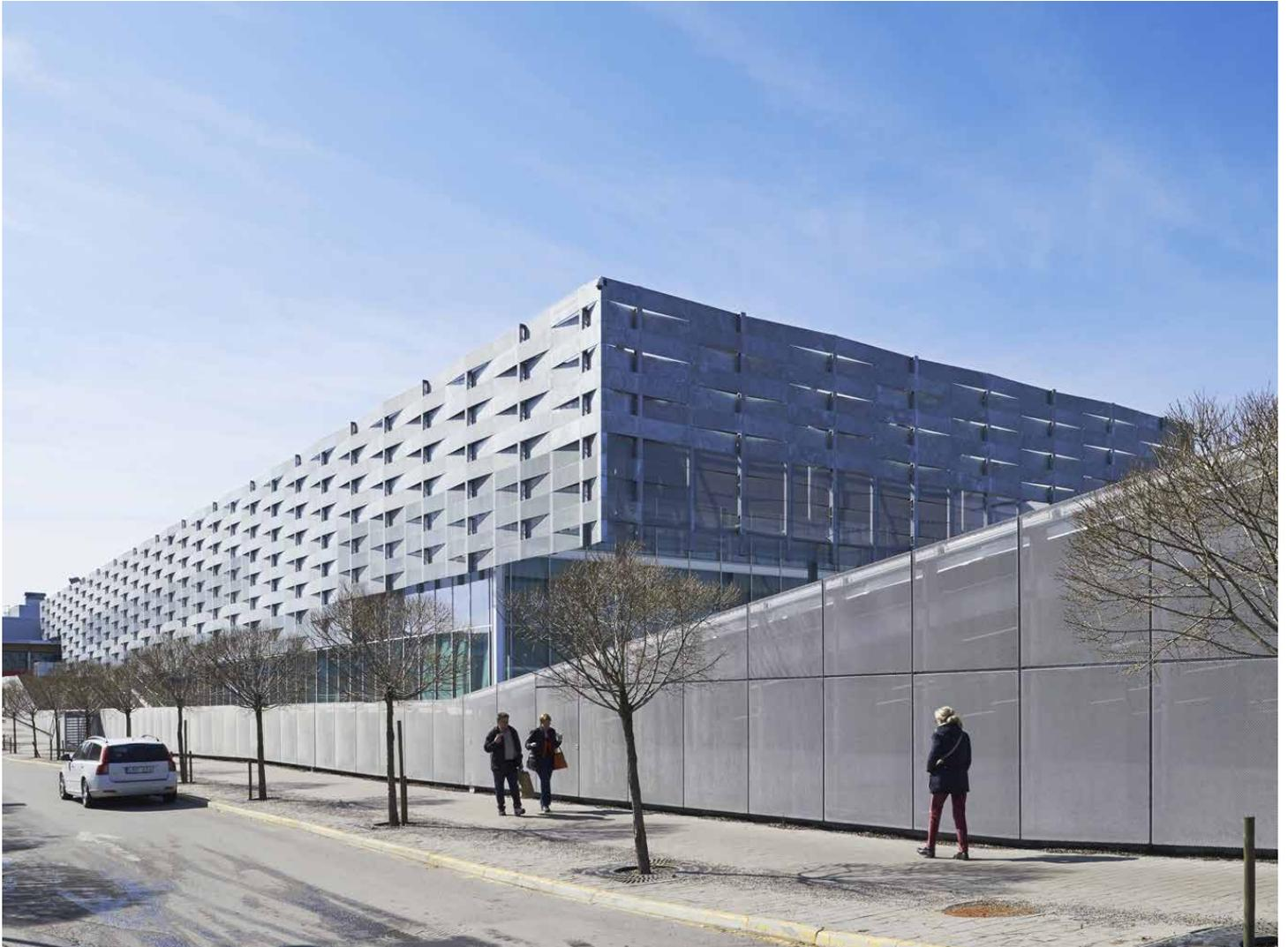
El nuevo edificio hace un uso innovador del acero a lo largo de toda la estructura principal y el sistema de revestimiento, estrechamente integrados. Externamente, el AE-Hall está envuelto en una fachada de acero galvanizado: una cáscara metálica gigante que crea un efecto de relieve reforzada por accesorios de iluminación integrados en la estructura galvanizada. La pantalla está hecha a partir de 1.500 paneles de acero galvanizado perforados.
