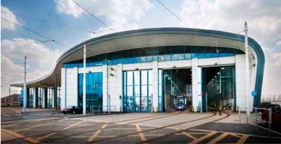
El edificio, cuya estructura contiene 400 toneladas de acero galvanizado, se extiende por una superficie de 66 metros de longitud por 12 metros de ancho. El ingenioso diseño del techo refleja la proximidad del mar, con vigas que alternan suavemente en direcciones opuestas a imitación de las olas del océano.
