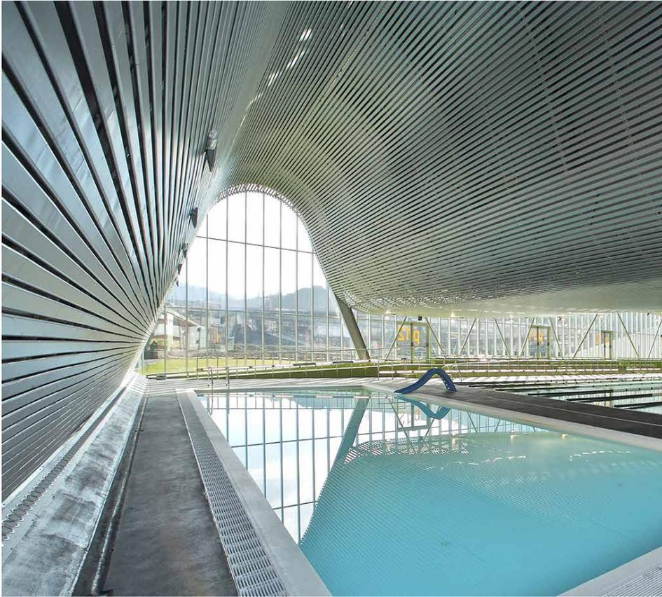
*En el área de la piscina, que por tanto presenta un alto índice de corrosividad, el techo fue diseñado con malla de acero galvanizado y recubierto adicionalmente.*
