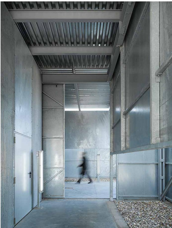
El acero galvanizado se utiliza en este edificio de manera indispensable para construir el espacio. Se lleva a sus dimensiones máximas de fabricación y se ensambla con tornillos, construyendo dentro un espacio que se llena con aire, luz y sombra, mientras el exterior reacciona poéticamente con su brillo metálico, en una deliciosa interpretación trémula de la luz y el color.
