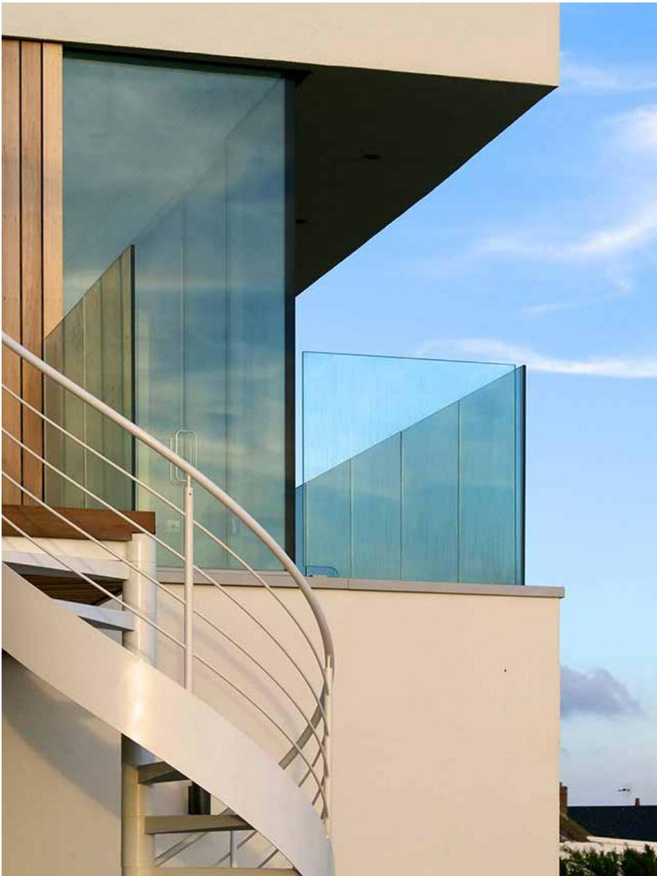
*Un sistema Dúplex de galvanización en caliente y pintura protege la elegante escalera de caracol de la corrosión.*
